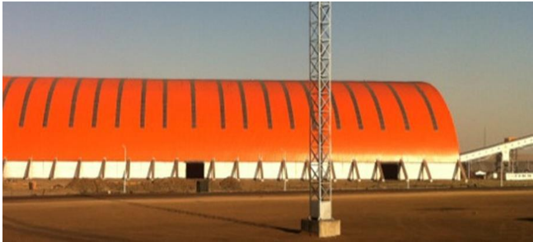
图 2-4 栈桥式储煤场图
